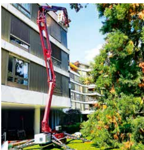
Ausgebessert wurde die Fassade der Überbauung Hirzbodenpark. Foto: Madeline Merz
