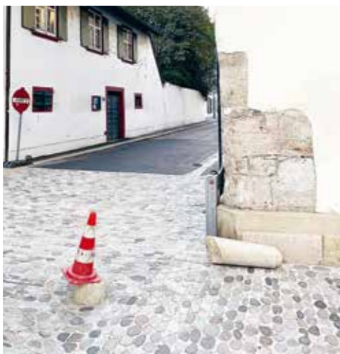
Repariert werden musste dieser Steinpfosten an der Ecke St. Alban-Vorstadt/Malgasse sogar zwei Mal. Foto: Beata Wackernagel
