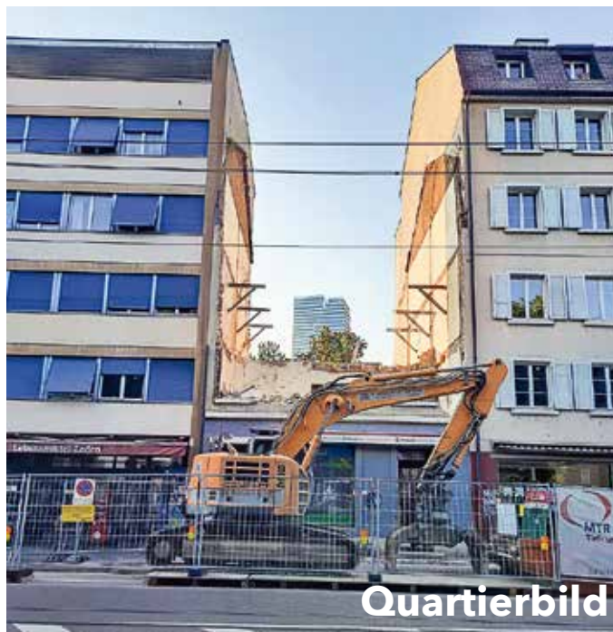
Neue Aussichten eröffnen sich nach Abbrucharbeiten an der Zürcherstrasse. Foto: bli
