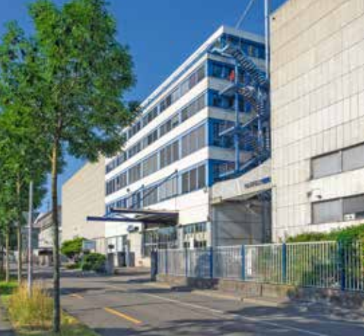
Das Alte Kraftwerk an der Birsstrasse (hinten) und der Haefely-Bürotrakt bleiben erhalten, die übrigen Gebäude werden zurückgebaut. Foto: WK
