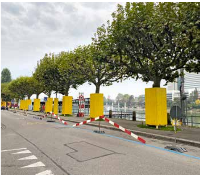
Nicht als Kunstinstallation , sondern wegen Bauarbeiten wurden die Bäume am St. Alban-Rheinweg eingepackt. Foto: Thabea Bucher
