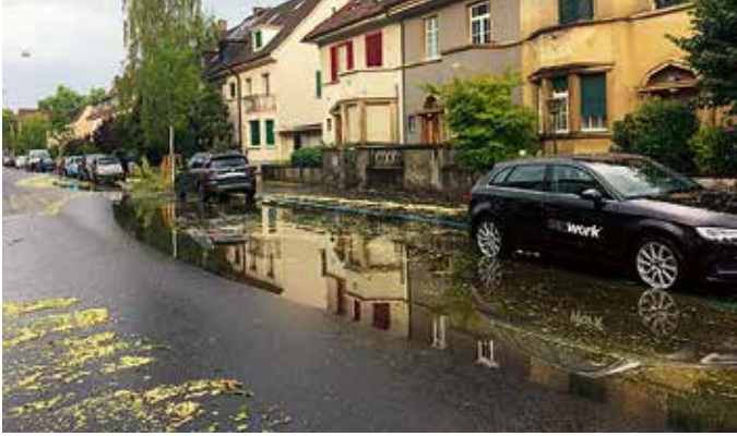
Nach der Umgestaltung des St. Alban-Rings kommt es hier zu Überschwemmungen. Foto: Annemarie Haag
