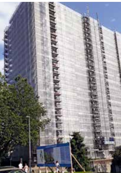
Die Hochhäuser an der Redingstrasse im Gerüst, davor ein Plakat mit der Zukunftsvision. Foto: pu
