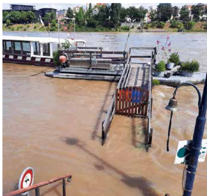
Überflutet wurde der Zugang zur St. Alban-Fähre von ebendiesem Regen. Foto: Sigfried Schibli
