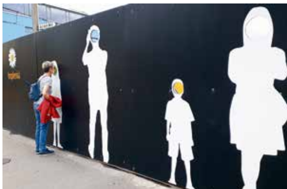
Bei der Tram- und Bushaltestelle Dreispitz sind Jung und Alt eingeladen, einen Blick in die Baustelle zu werfen. Foto: Pu
