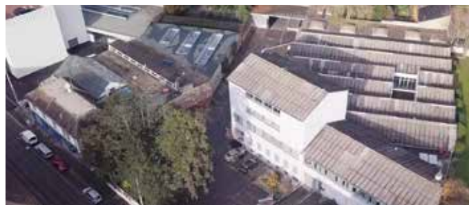
Bauprojekt an der Hardstrasse: Die charakteristische alte Shedhalle (im Bild rechts oben) bleibt bestehen. Foto z.V.g.
