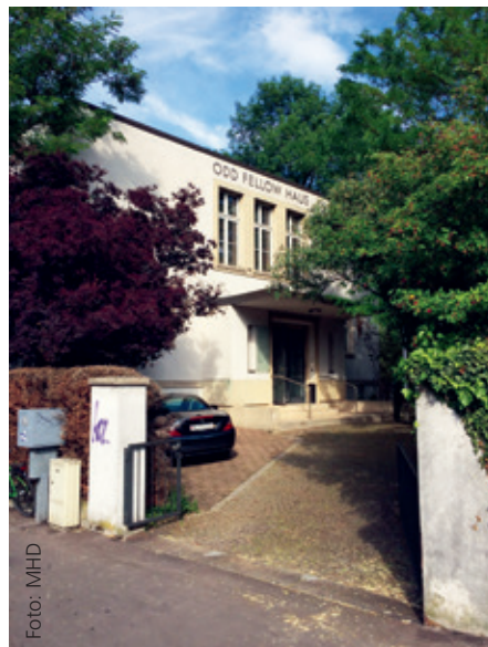
Das alte Odd-Fellow-Haus an der Grosspeterstrasse hat ausgedient.
