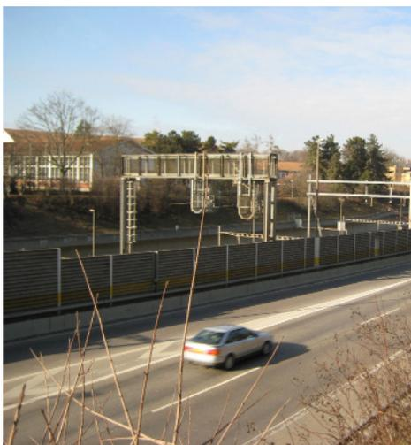
**Um die Lärmemissionen in die Basler Quartiere zu reduzieren, ist ein Lärmsanierungsprojekt für die Osttangente ausgearbeitet worden.**
