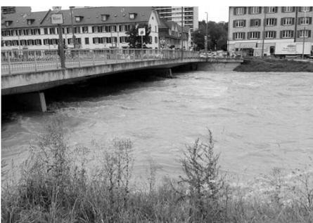
Die 33jährige Redingbrücke über die Birs muss altersbedingt instand gesetzt werden. Die Bauarbeiten beginnen am Montag, 18. Mai, und dauern bis ungefähr Mitte August 2009. Dabei werden insbesondere die Abdichtung und der Brückenbelag erneuert. Es sind aber auch weitere Mängel an der Brückenkonstruktion und unter anderem Betonabplatzungen zu beheben. Der Ver-
