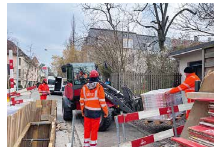
Vom Ausbau der Fernwärme am Hirzbodenweg war auch die Anlieferung des Quartierkuriers betroffen. Die Bauarbeiter und ein Bagger leisteten kreative Abhilfe. Foto: Beata Wackernagel
