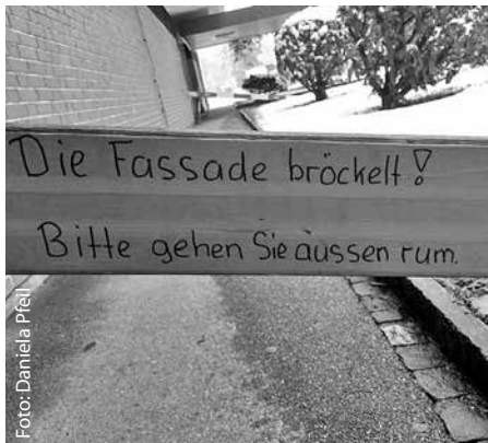
Im falschen Film: Die Fassade bröckelt an der Redingstrasse.
