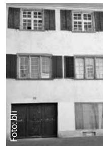
Ein Wohnhaus verwittert vor sich hin.
