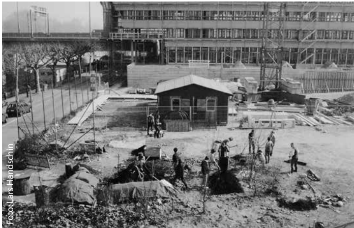
Hier entsteht die Ines Loos-Anlage inkl. Kompoststelle (29. Februar 1992).
