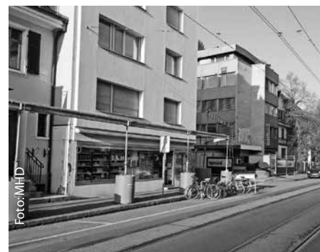
Baustromleitung zum «Schandfleck»
